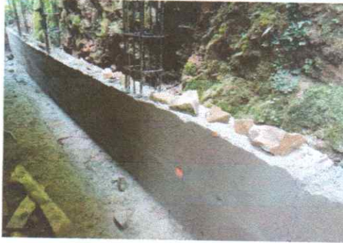
Foto 1: Construcción de muro de concreto
