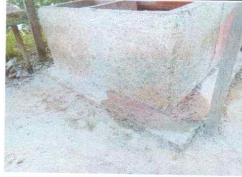
Foto 2: Reparación de pila de cemento de un lavadero
