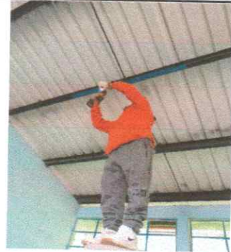
Foto 4: Instalación de sistema eléctrico
