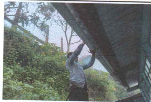
Foto 6: Colocación de canal de pvc pluvial
